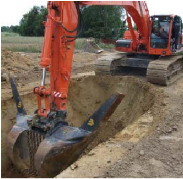
Figura 3-2 Scavo della trincea
